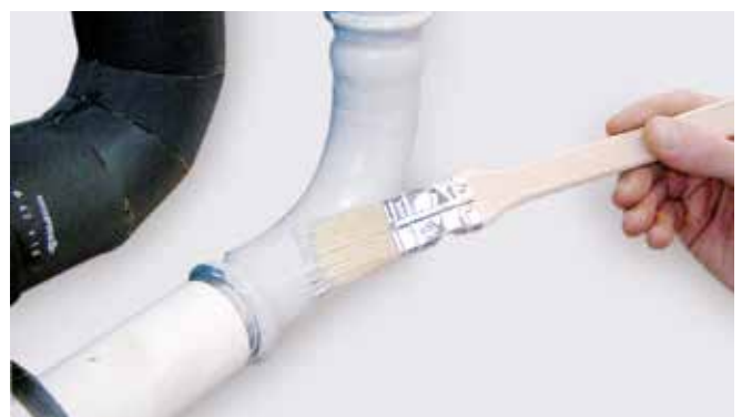
Fig 34 - Stryk anslutningar och rör med primer.
