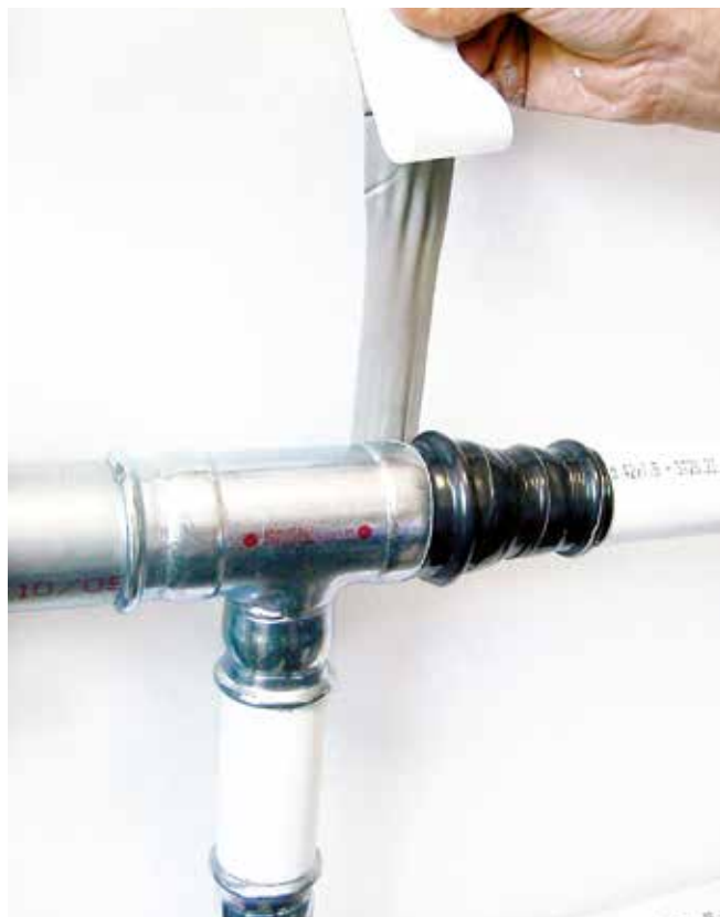
Fig 35 – Skydd av anslutningar med butanol vidhäftande tejp
