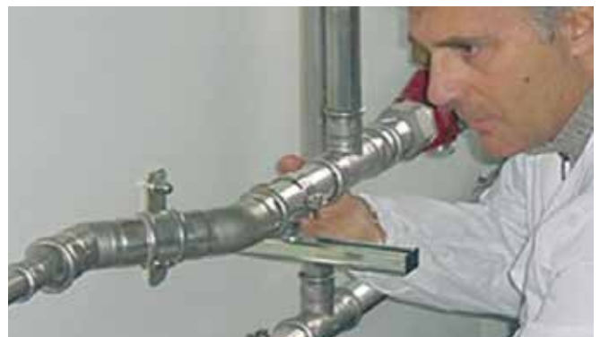
Fig 33 - Kontroll av press anslutningen
