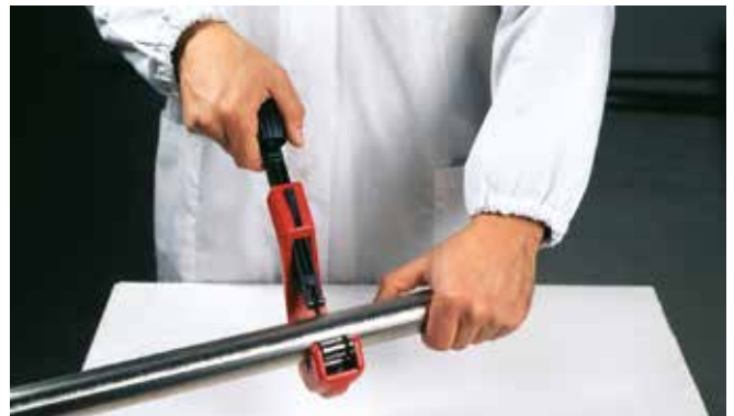
Fig 25 - Kapa rör till rätt längd
