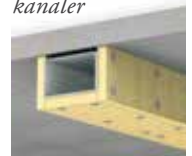
Brandisolerade ventilationskanaler
