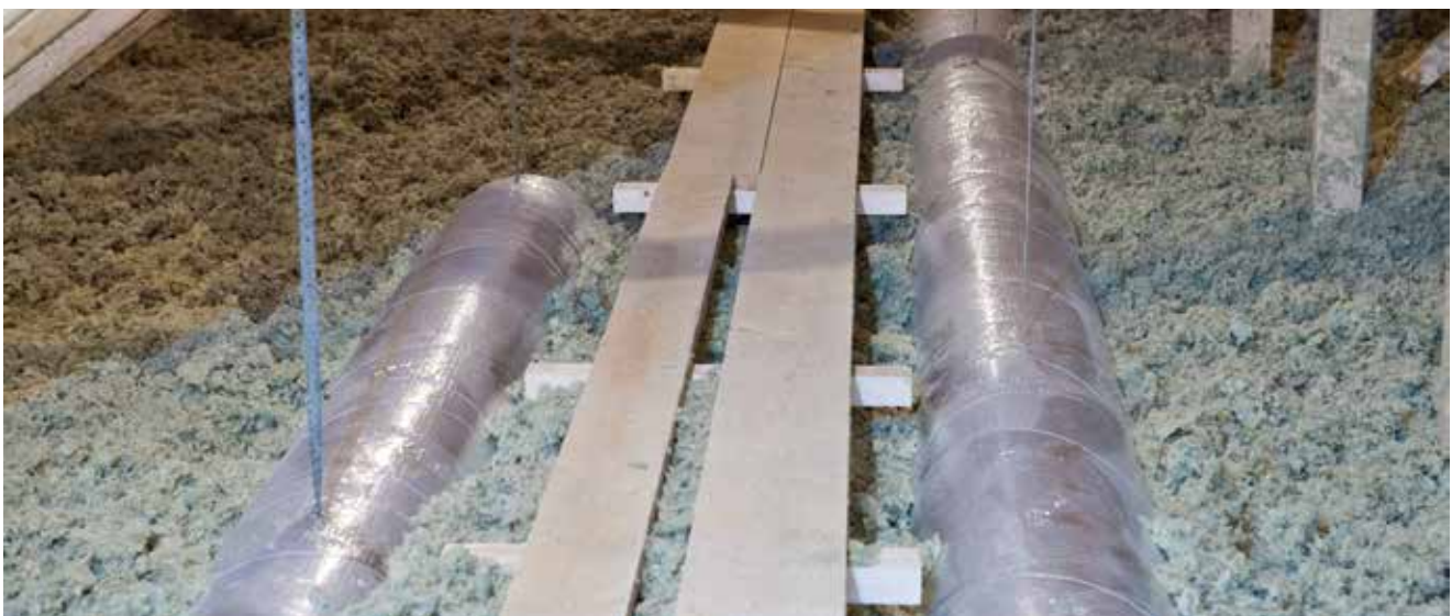
PAROC Hvac AirCoat är en brandgodkänd helhetslösning för isolering av cirkulära ventilationskanaler. Vid installation i lösull rekommenderas 50 mm isoleringstjocklek och när installation sker ovanför lösullen rekommenderas 120 mm tjocklek.
